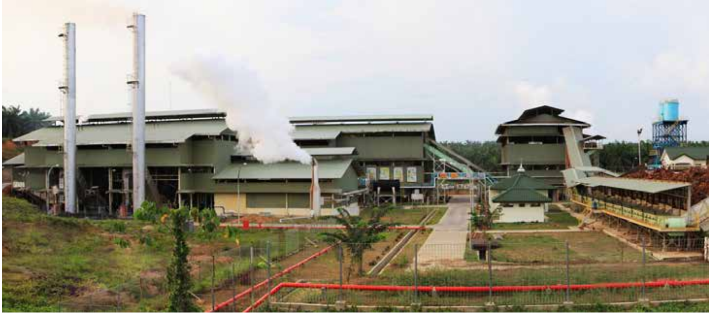
Pabrik pengolahan minyak sawit mentah PT Sukses Tani Nusasubur, Kalimantan Timur CPO Mill of PT Sukses Tani Nusasubur, East Kalimantan
