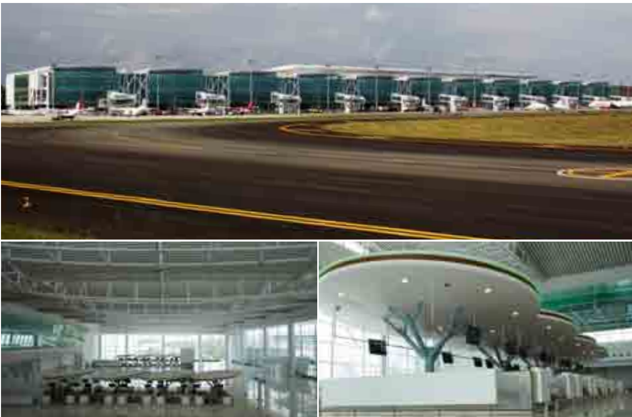
Bandar Udara Sepinggang, Balikpapan - Kalimantan Timur Sepinggang Airport, Balikpapan - East Kalimantan
