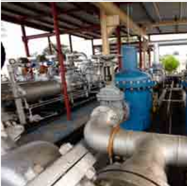
Pipeline Plaju, Palembang - Sumatera Selatan Pipeline Plaju, Palembang - South Sumatera
